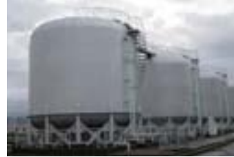
薬品貯蔵施設
