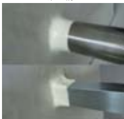
複雑な形状にも正確に施工
