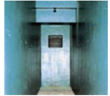
地下排水処理槽
