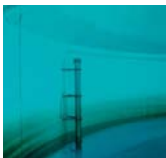
PC配水池 10年経過状況
