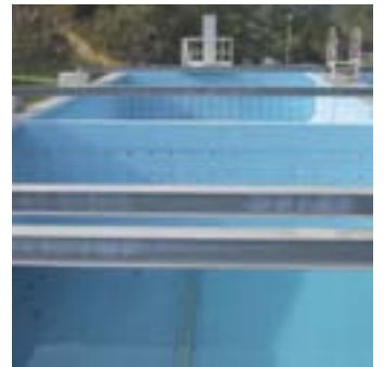
浄水場沈殿池
