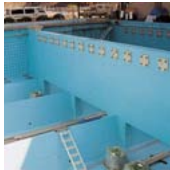
浄水場沈殿池
