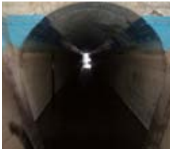
水路トンネル 17年経過状況
