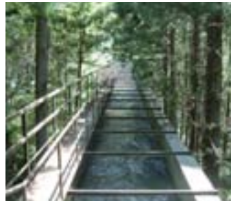
水路橋 18年経過状況
