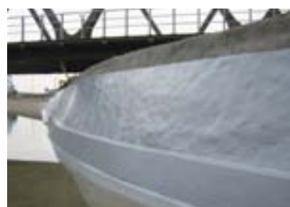
水路 防水 劣化防止
