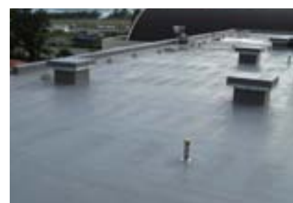
屋上防水 環境配慮 遮熱性
