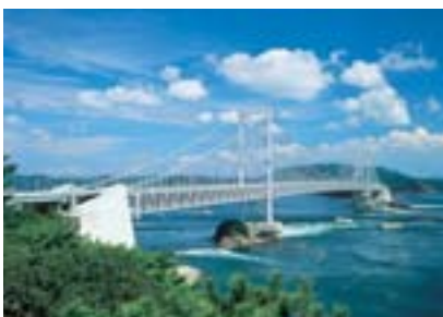
橋梁 塩害対策
