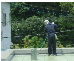
FRPライニング
