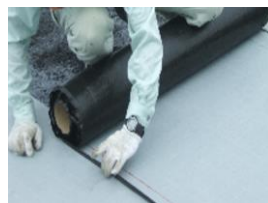
JTシート貼り
