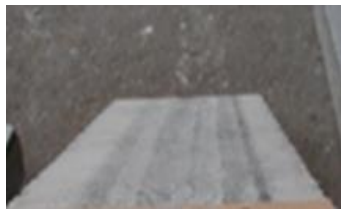
コンクリート板
