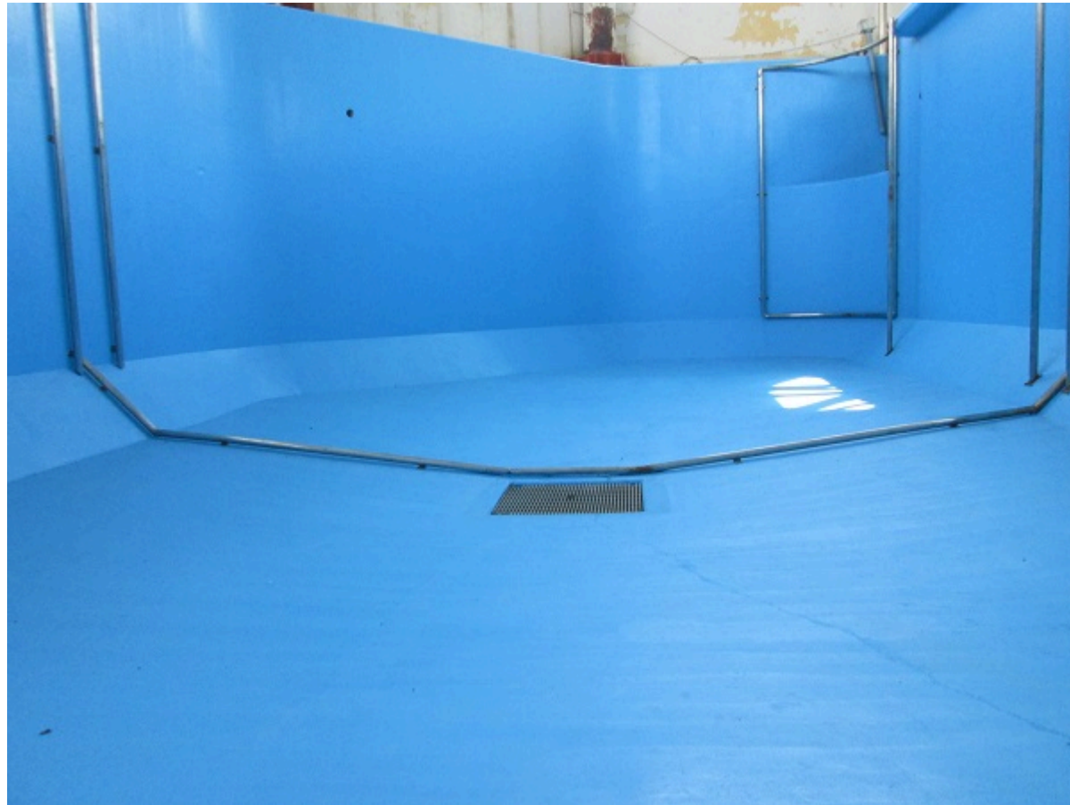
のとじま水族館イルカプール
